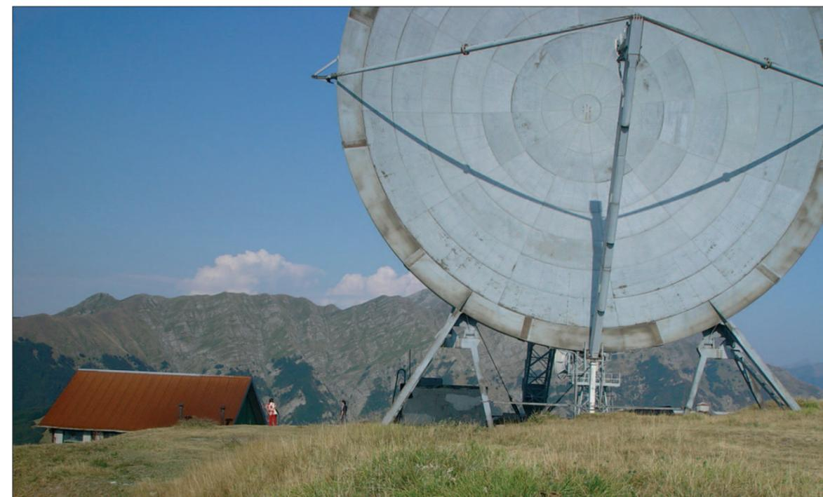
Paraboloide da venti metri di diametro della stazione Troposcatter di Monte Giogo (Massa Carrara), diretto a ovest. L'antenna, ideata per il sistema ACE HIGH, è di produzione Krupp.
