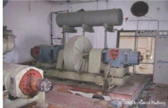
*No-Break con cisterna carburante per il Generatore (sopra) ed il pannello di controllo e stabilizzatore No-Break e Generatori*
