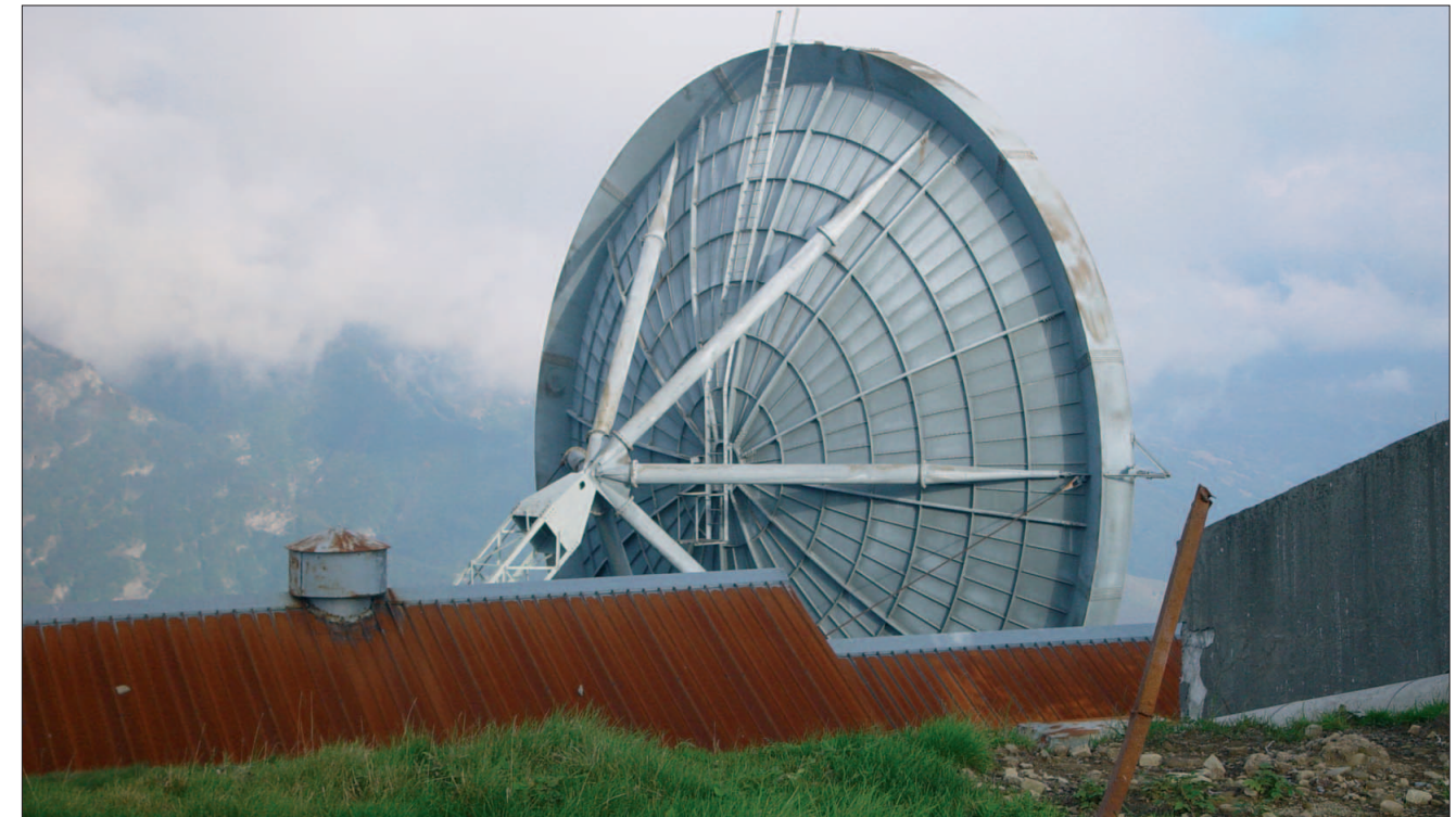
La parte posteriore di uno dei paraboloidi di venti metri di diametro del Monte Giogo: è uno dei due puntati in direzione della base Troposcatter NATO romana della Tolfa, posta circa quaranta chilometri a nord di Roma.
